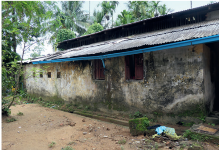
Der Anbau für Sanitär- anlagen im Waisenhaus in Myeik wird 2023 renoviert.
