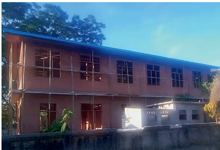
Schulhaus Kalay im Bau
